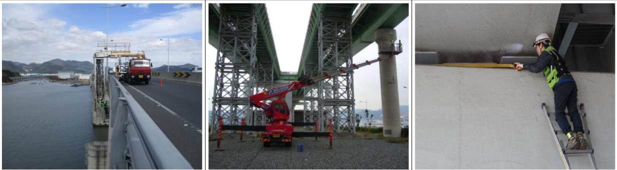
도보 육안조사 및 고소 점검차 이용
