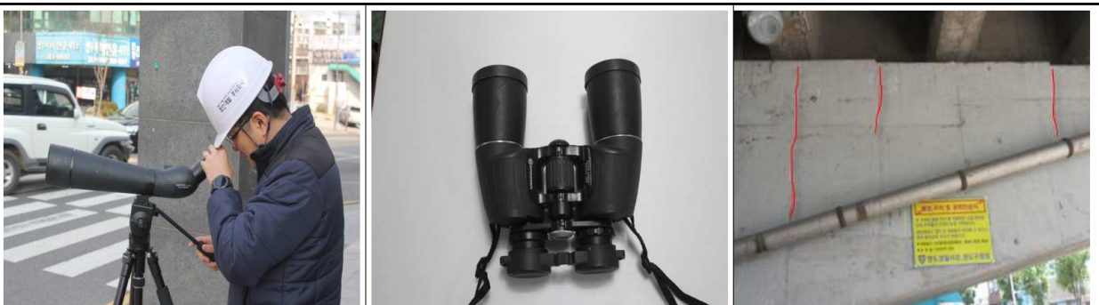
망원경을 이용한 외관조사
