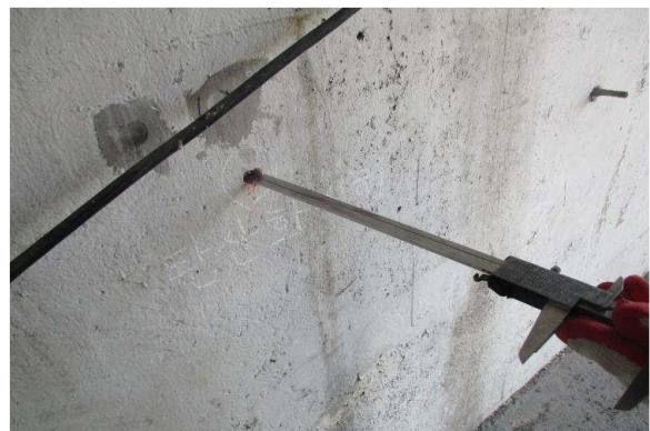
탄산화 깊이 측정
